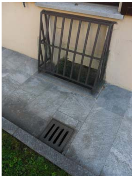
Caditoia e pozzo interrato, fronte est Municipio, sotto finestra Ufficio Comandante
