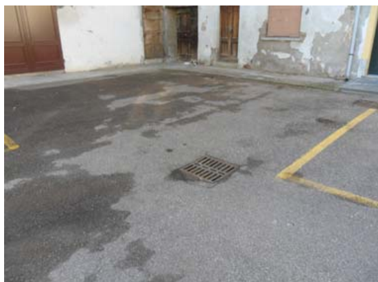
Vista cortile sud – notare presenza caditoia
