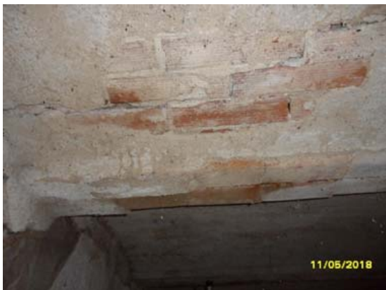
Vista solaio in volterrane – locale 2
