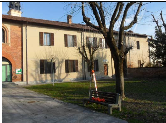
Lato ovest edificio comunale, vista attuale.
