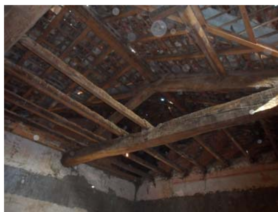
Vista interno copertura - locale 4
