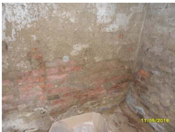
Situazione murature ed intonaci – locale 2
